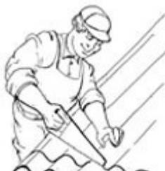
Разрезать листы можно ножовкой по дереву, смазанной маслом для того, чтобы избежать застревания. Можно использовать циркулярную или ручную электропилу.
